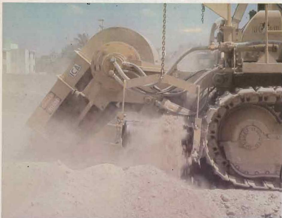
La excavadora de zanjas Roc-Saw trabajando en las calles de Mérida. Note la cantidad mínima de material sobrante depositado prolijamente al lado de la zanja.
