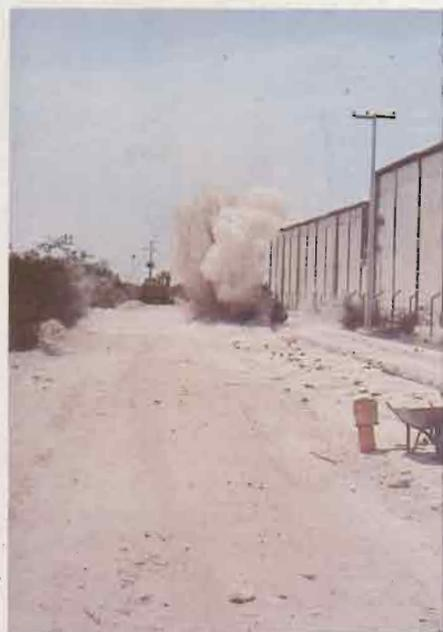
Dos pases de la Roc-Saw a cada lado del ancho deseado de la zanja controla el efecto de la carga de dinamita haciendo segura la explosión a una distancia tan cercana a las estructuras.
