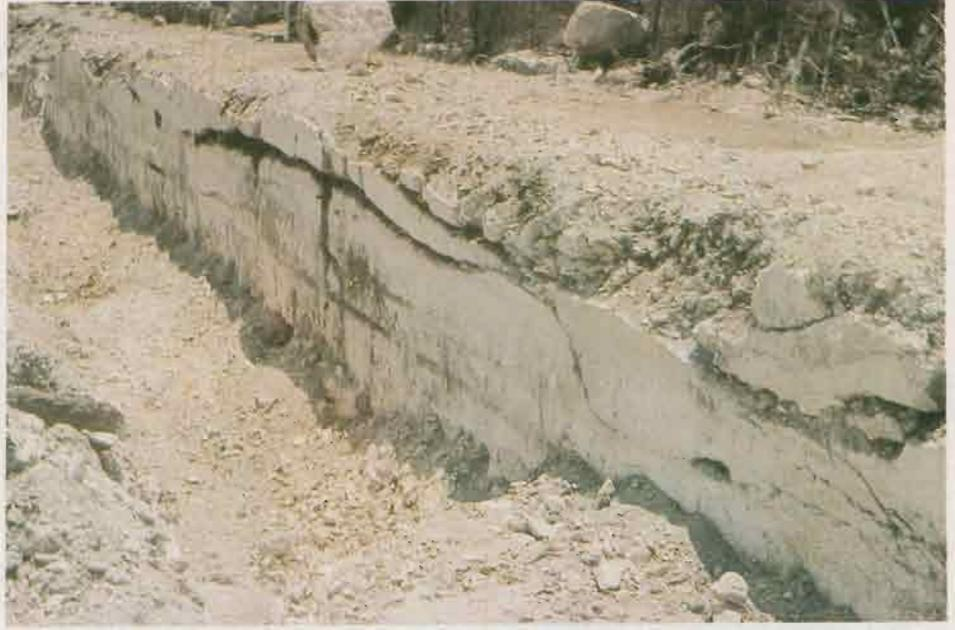
Area del corte de la Roc-Saw de la misma dureza de roca. Note el corte limpio de los bordes y los mínimos escombros obtenidos con esta técnica.
